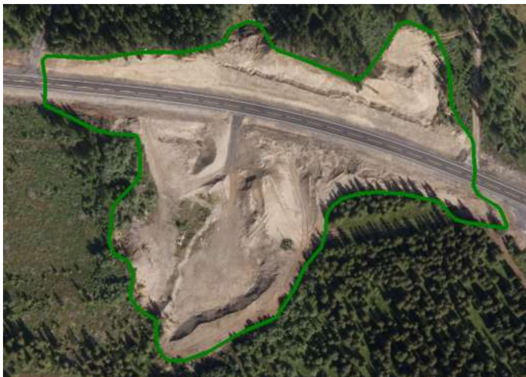
Figur 15: Eksempel på registrering av anleggsområde. Her er det riktig å registrere vegen som i prinsipp er ferdigbygd.
