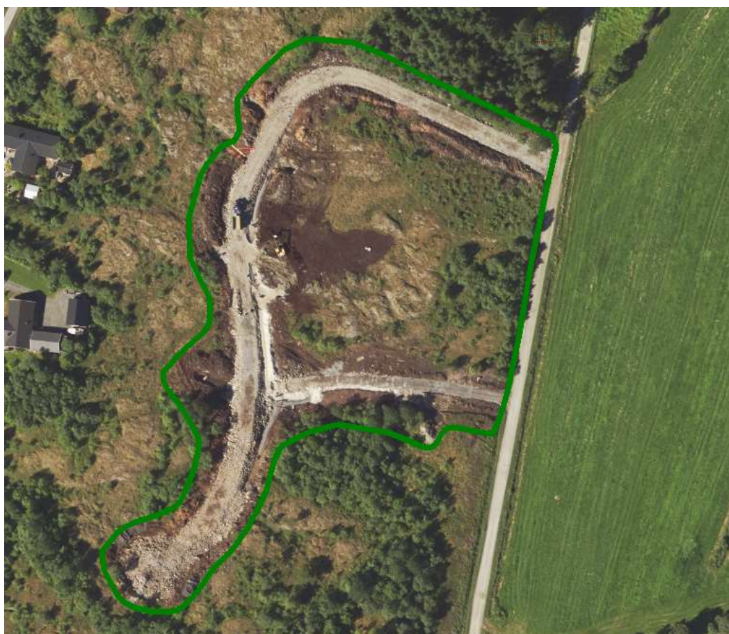
Figur 16: Eksempel på registrering av anleggsområde. Her skal ikke den påbegynte vegen og grøfter registreres.
